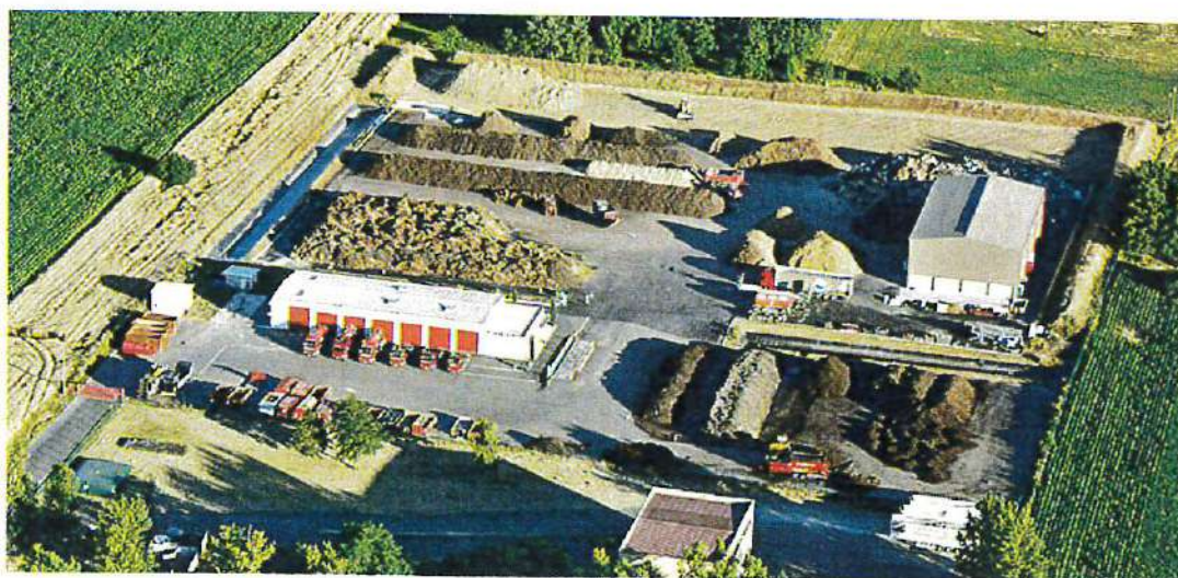
Plateforme de compostage de Castelsarrasin
